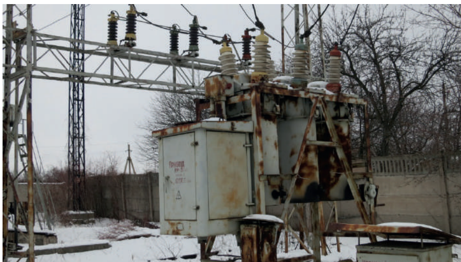
Зовнішній масляний вимикач потужністю 35 кВ, пошкоджений у результаті обстрілу
