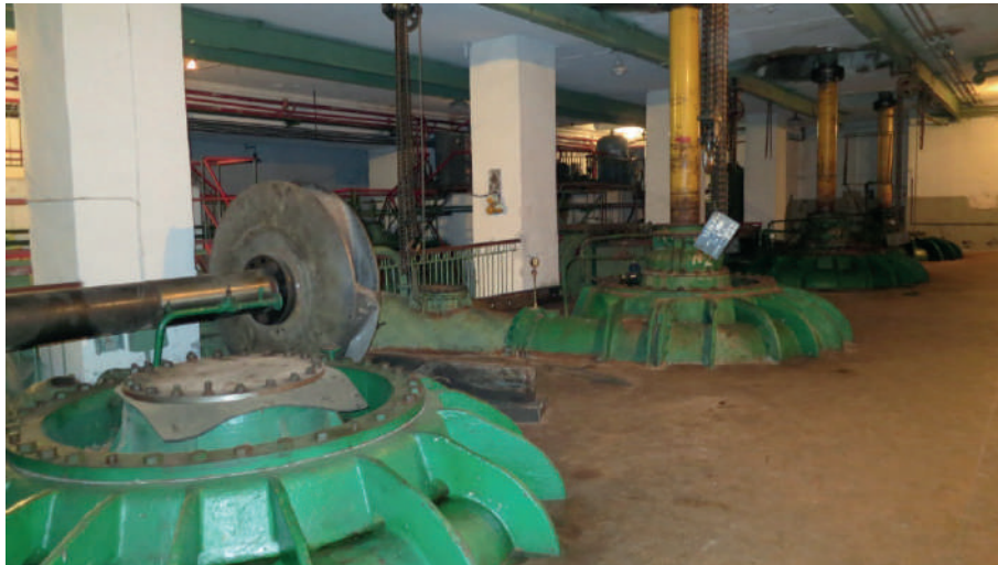
Насосне обладнання насосної станції 3, № 1, демонтовано
