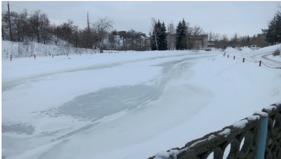
Канал СДД, покритий кригою, в районі водозабірному вузла Насосної станції 3
