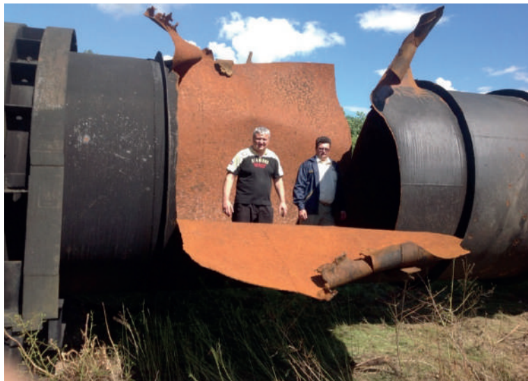
Пошкоджений напірний трубопровід каналу Сіверський Донець – Донбас
