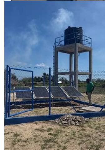
One of the Water Supply Systems rehabilitated after Cyclone Jude Um dos Sistemas de Abastecimento de Água Reabilitados após o Ciclone Jude
