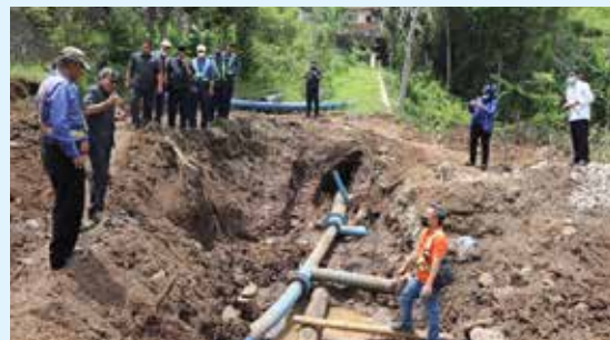
GAMBAR 13 PENGGANTIAN PIPA SETELAH KEJADIAN BANJIR BANDANG 9
