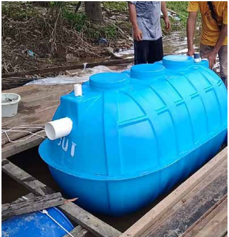
INSTALASI BIOSEPTICTANK UNTUK WC APUNG
