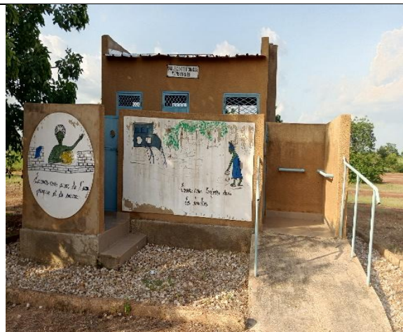
Latrine dans le CSPS
