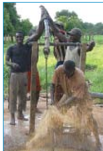
Dragage et colmatage à la boue
