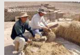
Beneficiarios cortando paja para ser mezclada con barro y producir bloques de adobe. Comienzo de las actividades para la mejora de los medios de vida y desarrollo de capacidades.
