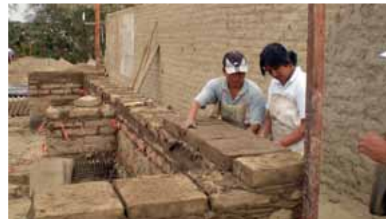
Casas construidas con adobe reforzado y bambú, para la estructura de cubierta, con la universidad, La Católica.
