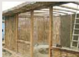
Construcción con quincha mejorada con PREDES.
