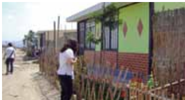
Casas construidas con quincha mejorada en Bernaldes con PREDES.
