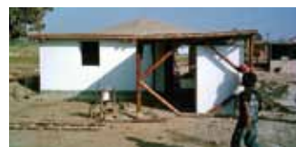
Trabajos de construcción con adobe reforzado con la universidad, La Católica.
