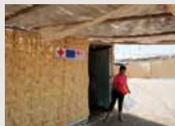
Octubre 2007: Comienza la construcción de los alojamientos transicionales en Bernales.
